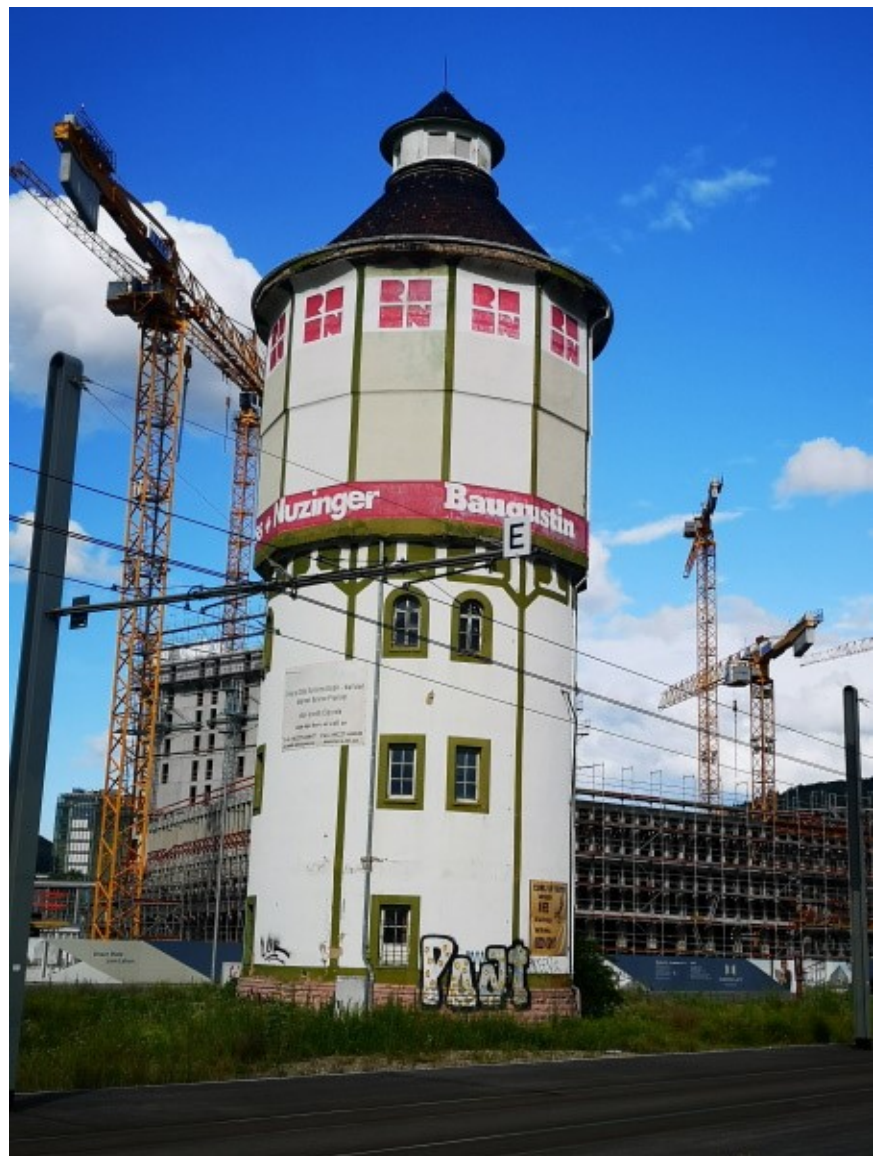
Der Wasserturm wird saniert und erhält einen Anbau (Foto: KoB.Ra)
