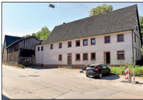
Die Merkel-Mühle in der Breitgasse 36 soll denkmalgerecht saniert werden. Foto: Dorn
